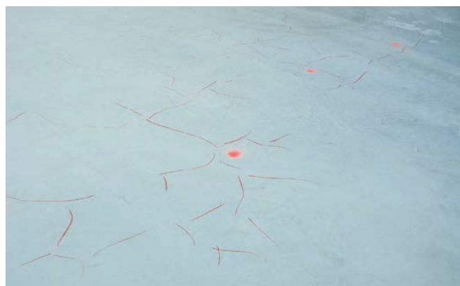
Bild 4: Über den ganzen Stall verteilte Krakeleerisse, nachgezeichnet
