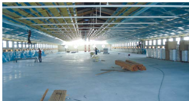
Bild 2: Innenansicht eines Stalls während der Dämmung des Daches
