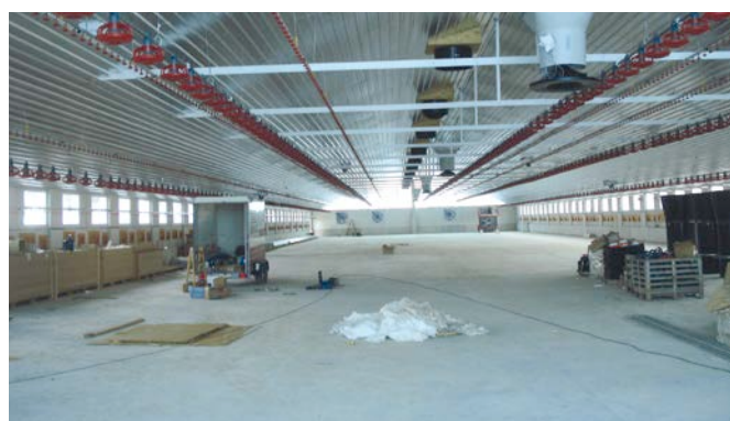
Bild 3: Stall mit fertiggestellter Dachdämmung
