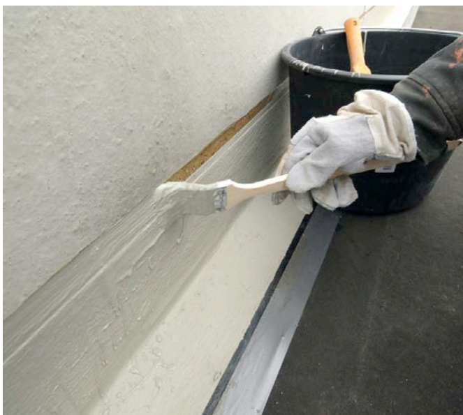
Bild 7: Versiegelung der abgedichteten Fuge
