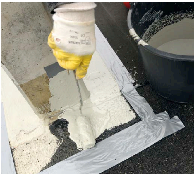
Bild 5: Auftragen des Abdichtungsharzes mit Rolle oder Pinsel
