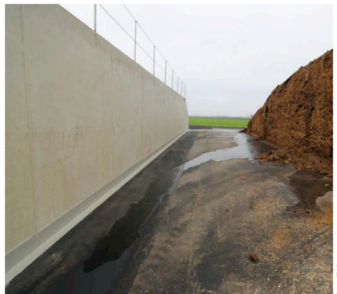
Bild 8: Fahrsilo mit instandgesetzter Fuge
