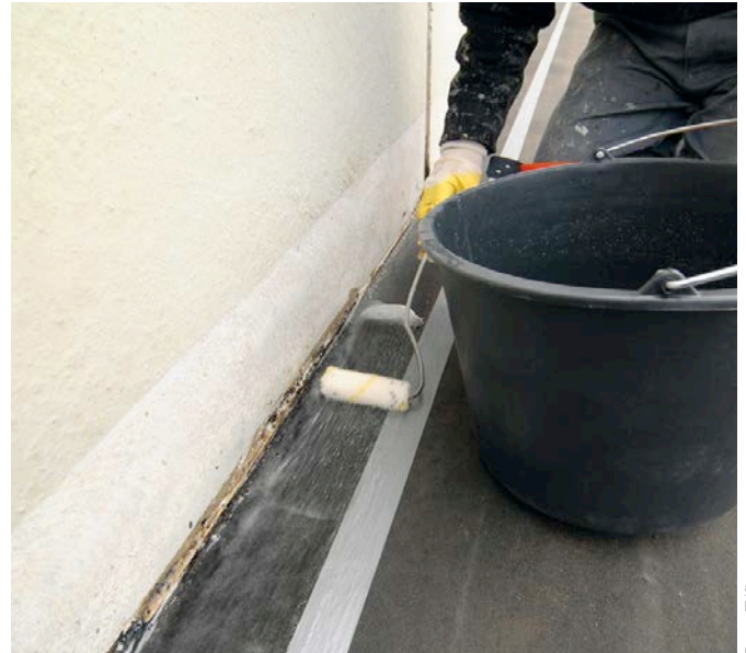
Bild 4: Grundierung der Anschlussfuge Bodenplatte - Wand
