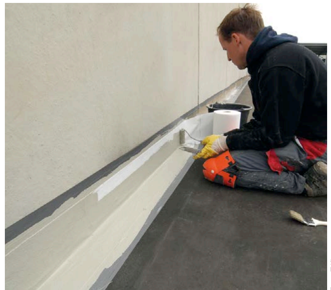
Bild 6: Einarbeiten eines Spezialvlieses in das Abdichtungsharz, danach Auftragen einer zweiten Abdichtungsschicht
