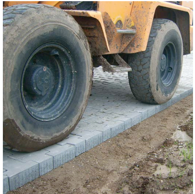
Bild 4: Speziell gestaltete Randsteine machen eine Einfassung überflüssig
