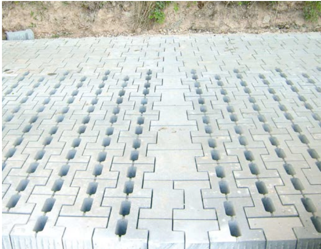
Bild 6: Kombination von Rasenkammersteinen und Vollsteinen
