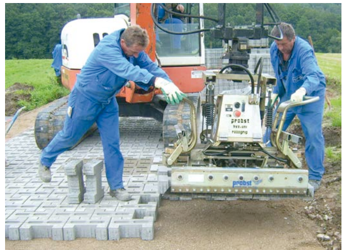
Bild 8: Maschinelle Verlegung des Pflasters
