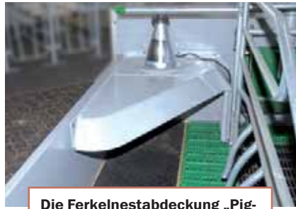
Die Ferkelnestabdeckung „Piggy-Corner“ besteht aus GFK und ist zweigeteilt. Der vordere Teil lässt sich hochklappen.
